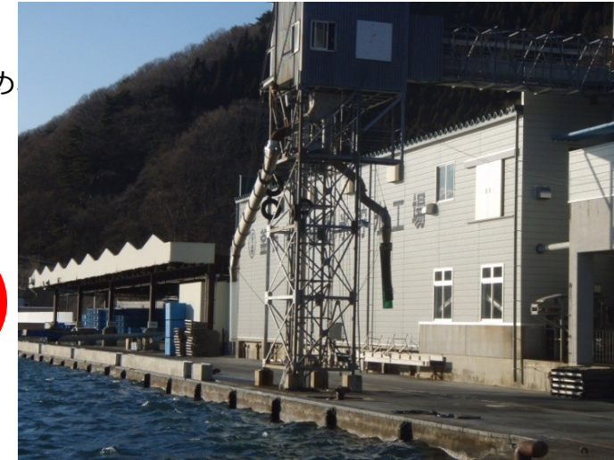
共同利用施設の復旧支援により整備した製氷・荷捌き施設 (釜石市)
