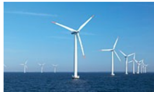
着床(底)式洋上風力発電
