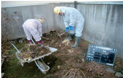
除染作業の様子
