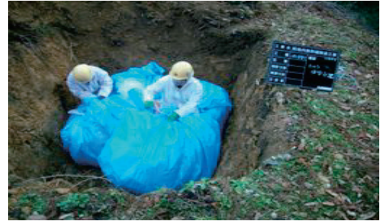
除染作業の様子
