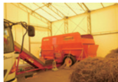
前処理施設（裁断機）の整備
