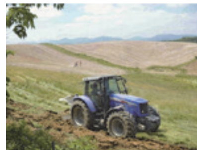
除染の様子（耕起作業）
