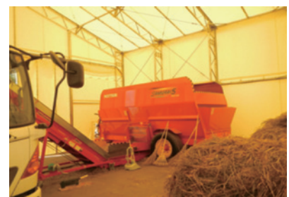
前処理施設（裁断機）の整備
