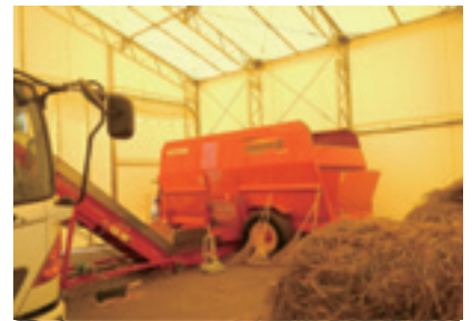
前処理施設(裁断機)の整備
