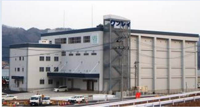
大船渡湾冷凍水産加工業協同組合 冷凍冷蔵施設(大船渡市)
