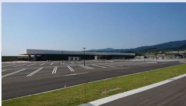
建設中の「東日本大震災津波伝承館」
