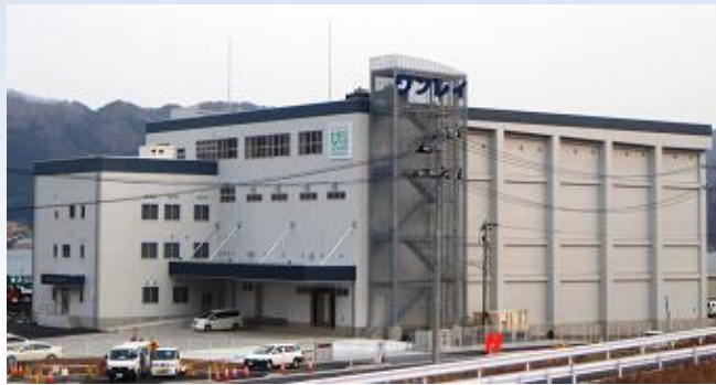
大船渡湾冷凍水産加工業協同組合 冷凍冷蔵施設(大船渡市)
