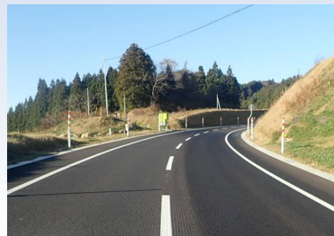
一般国道396号 上宮守工区 (R1.12.10開通 遠野市)
