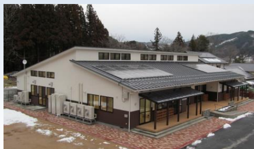
(宮古市：津軽石保育所太陽光発電設備)
