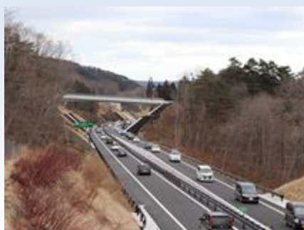
三陸沿岸道路 久慈北IC～侍浜IC R2.3.1開通
