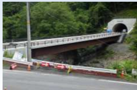
一般国道 281 号案内工区 (H29 年度開通予定 久慈市)
