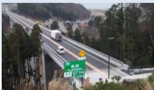
三陸沿岸道路（吉浜道路） (H27.11.29 開通)
