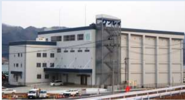
大船渡湾冷凍水産加工業協同組合冷凍冷蔵施設 (大船渡市、H29年3月完成)
