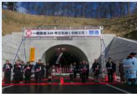
一般国道 340 号立丸峠（小峠工区） (H28. 12. 12 開通 宮古市)
