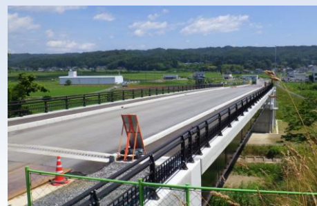
主要地方道野田山形線 野田工区 (H29 年度開通予定 野田村)
