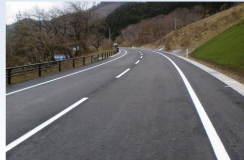
一般国道 397 号高屋敷工区 (H29. 12. 27 開通 住田町)
