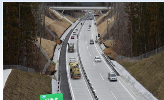
開通直後の状況
