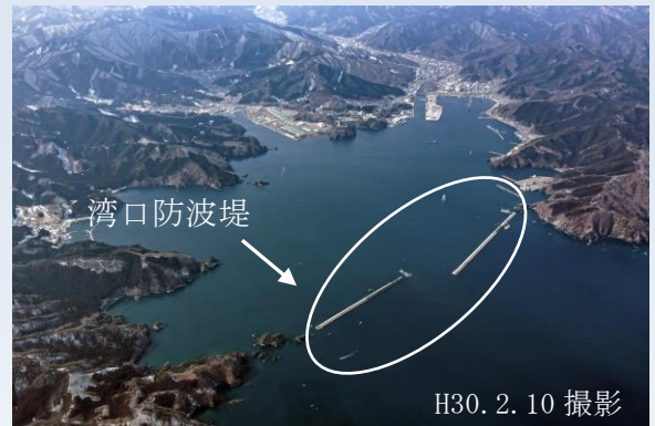
釜石港（完成） (写真：国土交通省東北地方整備局)
