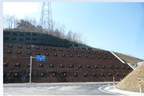
一般県道 田野畑岩泉線 室場の2工区 (H30. 3. 30 開通 田野畑村)
