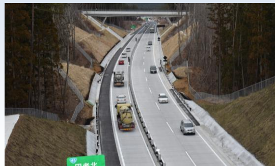
開通直後の状況
