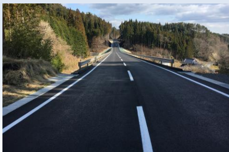
主要地方道 大船渡広田陸前高田線 大陽工区 (H30.3.16開通 陸前高田市)
