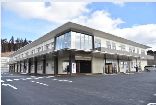
岩手県立高田病院 新築開院（平成30年3月）
