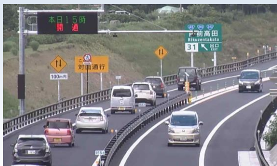
三陸沿岸道路 (陸前高田長部IC～陸前高田IC) H30.7.28開通 開通直後の状況
