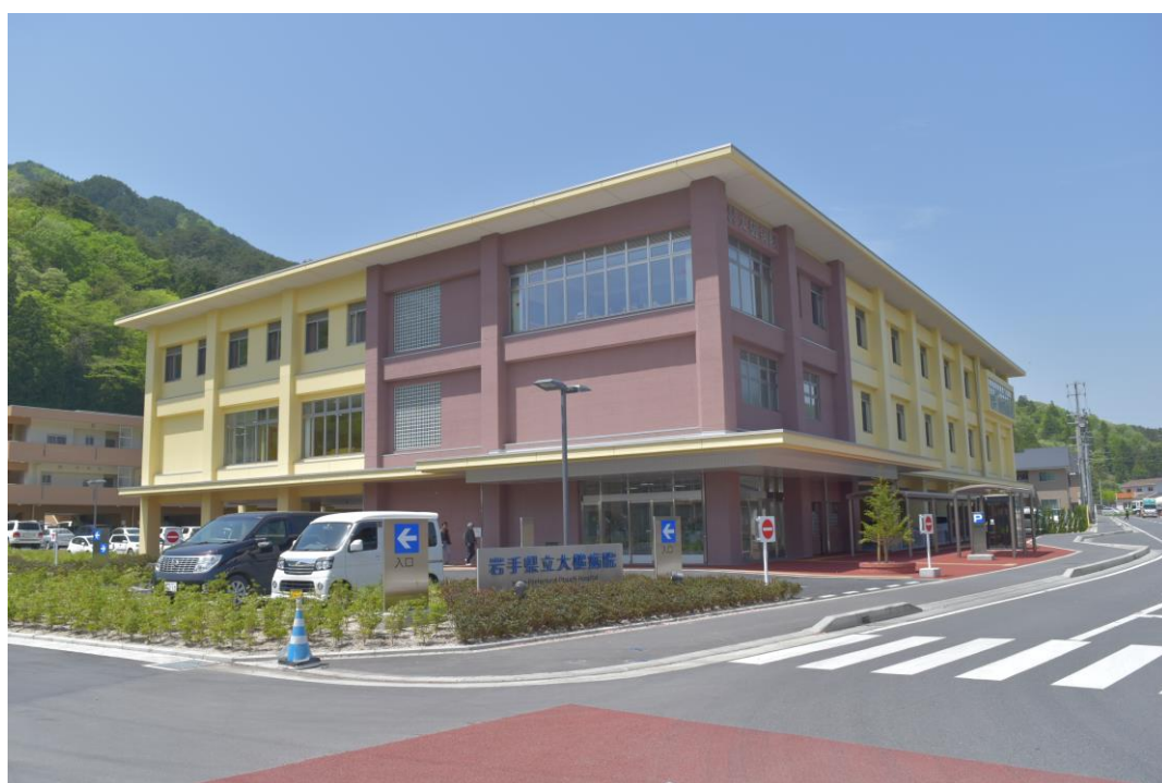
再建された県立大槌病院（大槌町、H28.5月）
