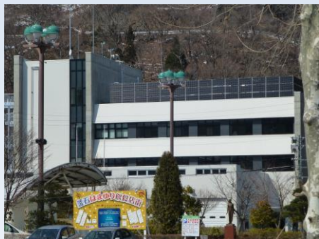
(釜石市：消防署庁舎の太陽光発電)
