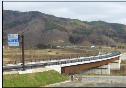
一般県道遠野住田線新里工区開通 (H27. 12. 5 遠野市)
