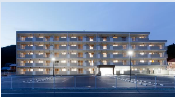
宮古市八木沢地区 (H27.10.27完成)
