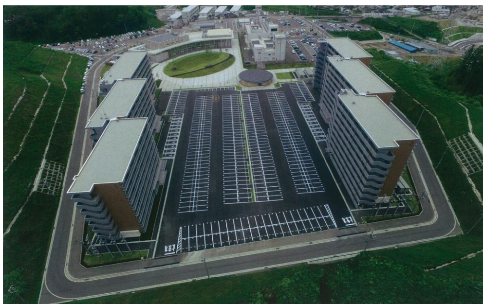
完成した栃ヶ沢地区の災害公営住宅（陸前高田市、H28.6月）
