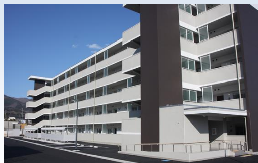
大船渡市関谷地区 (H28.3.22完成)
