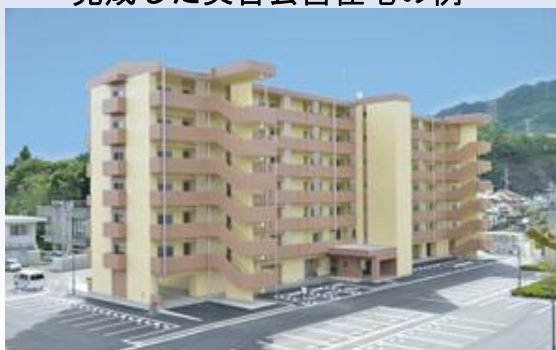
大船渡市下館下地区 (H28.9.30完成)
