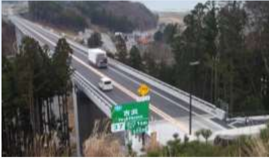
三陸沿岸道路（吉浜道路） (H27. 11. 29 開通)
