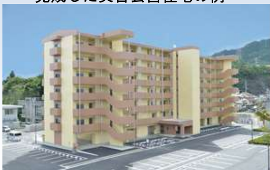
大船渡市下館下地区 (H28. 9. 30 完成)
