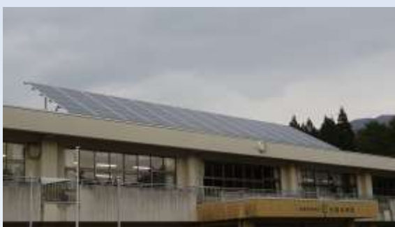
(陸前高田市：竹駒小学校の太陽光発電)
