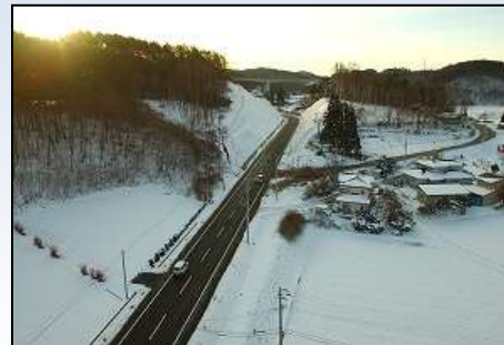
一般国道 340 号駒板工区開通 (H28. 12. 1 軽米町)
