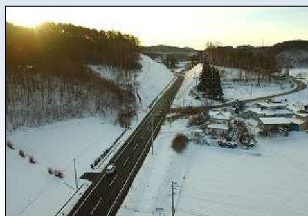
一般国道 340 号駒板工区開通 (H28. 12. 1 軽米町)
