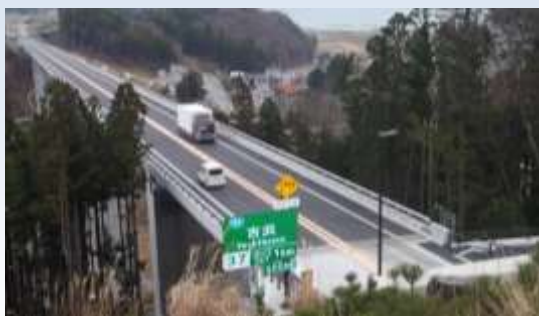
三陸沿岸道路（吉浜道路） (H27. 11. 29 開通)
