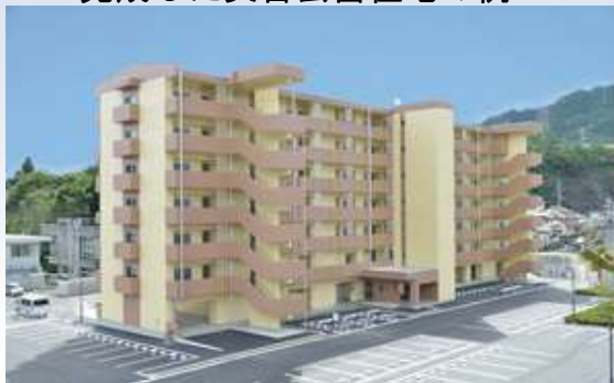
大船渡市下館下地区 (H28. 9. 30 完成)
