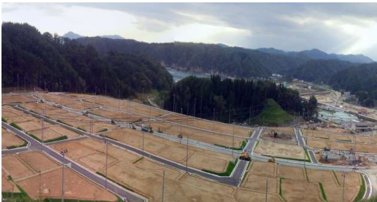
田老地区防災集団移転促進事業の住宅団地の整備状況（宮古市）
