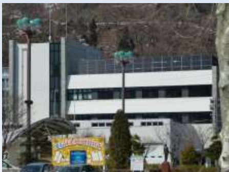
(釜石市：消防署庁舎の太陽光発電)
