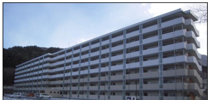
釜石市平田地区 (H26. 1. 24 完成)
