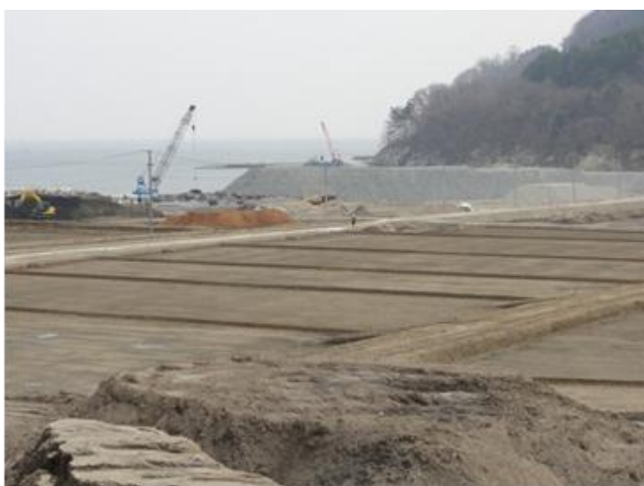
農用地災害復旧関連区画整理事業によるほ場整備工事の様子
