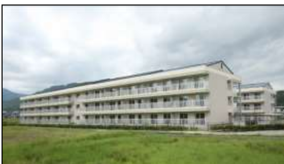
山田町豊間根地区（H26. 6. 27 完成）
