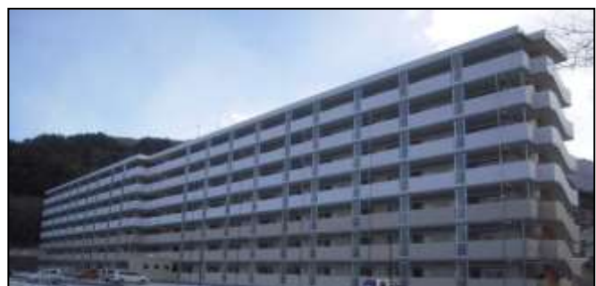
釜石市平田地区（H26. 1. 24 完成）
