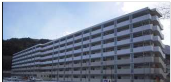
19 釜石市平田地区（H26. 1. 24 完成）
