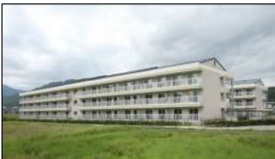
山田町豊間根地区（H26. 6. 27 完成）
