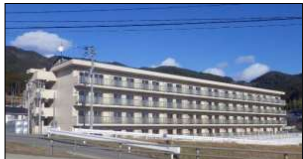
陸前高田市西下地区（H26. 12. 19 完成）
