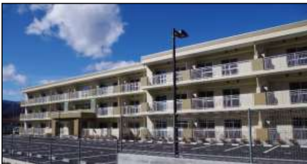
大船渡市下欠地区（H27. 1. 26 完成）
