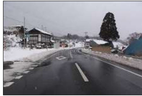
一般国道340号「泥ノ木」供用 (H27.1.16 九戸村)
