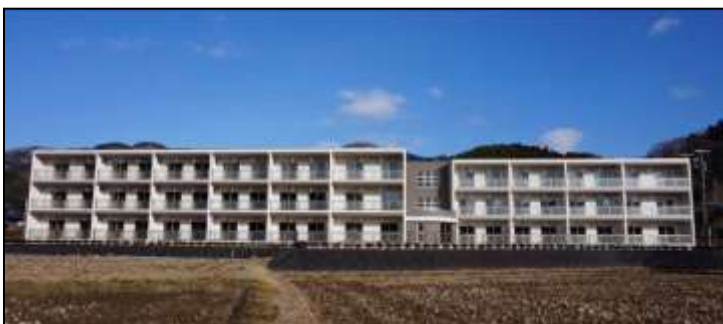
大船渡市綾里地区 (H27. 2. 10 完成)
