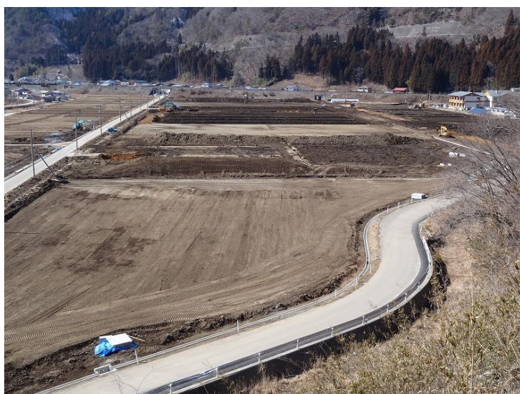
農用地災害復旧関連区画整理事業による県内最初のほ場整備工事の様子 (H25. 3.22 宮古市撰待工区)
