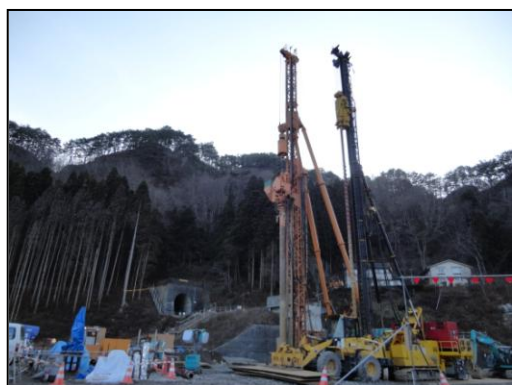
復旧工事中の三陸鉄道北リアス線 （H24. 12. 17 田野畑村 島越駅周辺）
