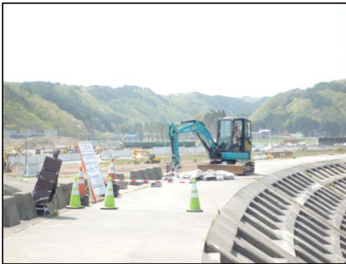
復旧工事中の防潮堤 (宮古市田老海岸)
