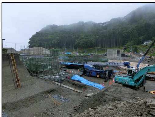
復旧工事中の三陸鉄道北リアス線
