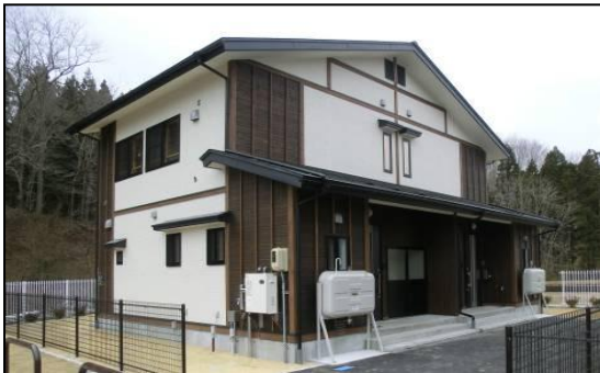
野田村野田地区 門前小路第1団地 (H25.3.25 完成)
