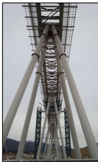
今泉地区から高田地区への土砂流用のため 気仙川に架設中の「希望のかけ橋」 (陸前高田市・H25.12.21撮影)
