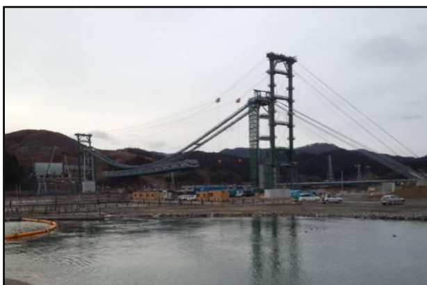
今泉地区から高田地区への土砂流用のため 気仙川に架設中の「希望のかけ橋」 (陸前高田市・H25.12.21撮影)
