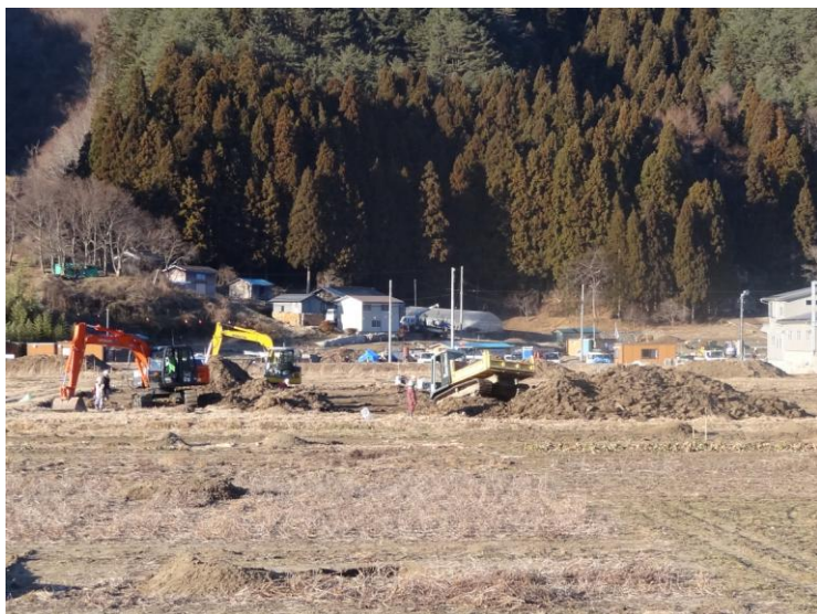
農用地災害復旧関連区画整理事業による県内最初のほ場整備工事の様子 (H25. 1. 11 宮古市摂待工区)
