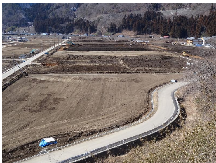
農用地災害復旧関連区画整理事業による県内最初のほ場整備工事の様子 (H25.3.22 宮古市摂待工区)
