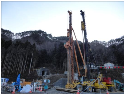
復旧工事中の三陸鉄道北リアス線
