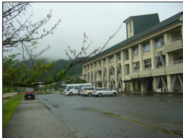
県立宮古工業高等学校の復旧の様子
