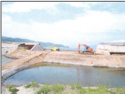
復旧工事中の防潮堤（宮古市金浜海岸）
