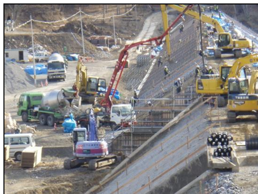
復旧工事中の三陸鉄道（野田村）
