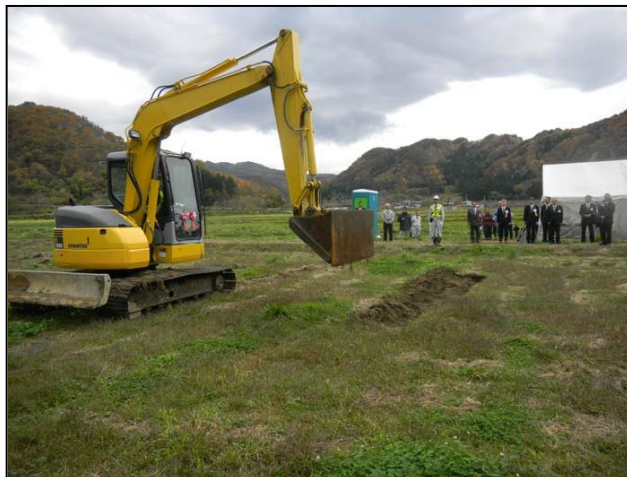
農用地災害復旧関連区画整理事業による県内 最初のほ場整備工事（宮古市摂待工区で着工）
