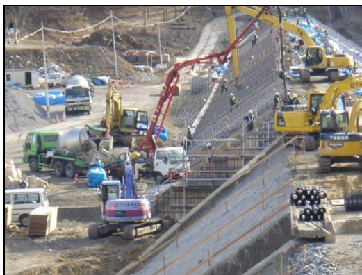
復旧工事中の三陸鉄道（野田村）
