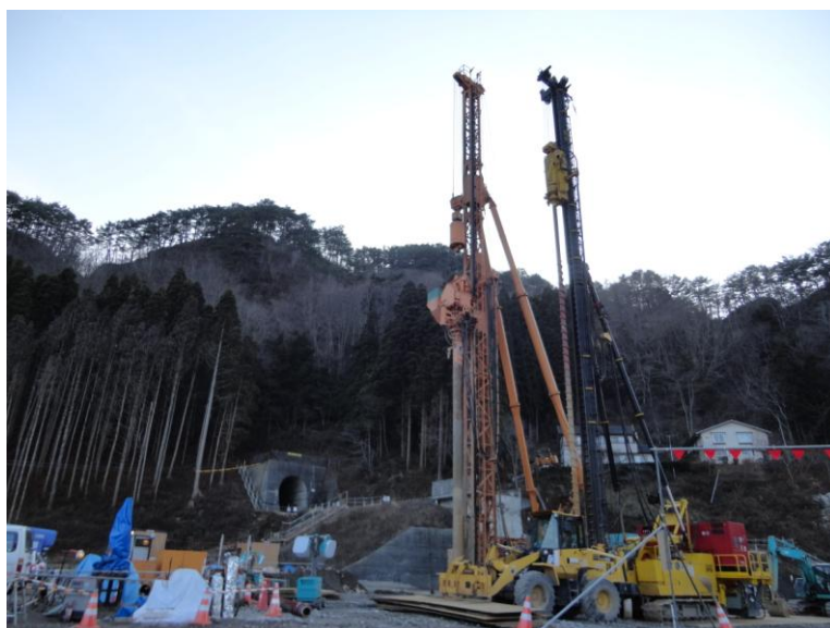
<三陸鉄道北リアス線島越駅周辺復旧工事の様子（田野畑村）> (H24.12.17 撮影)
