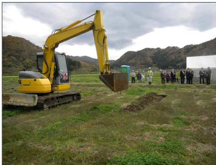
農用地災害復旧関連区画整理事業による県内最初のほ場整備工事が宮古市摂待工区で着工
