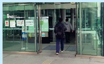
段差がなく誰もが同じように利用 することができる出入口
