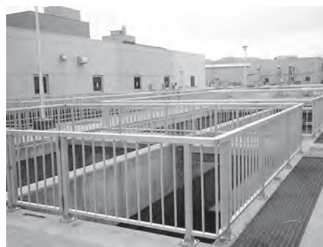
復旧後の大船渡浄化センター
