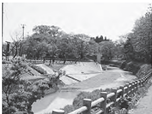
護岸の緩傾斜化により親水空間を創出した後川 (花巻市)
