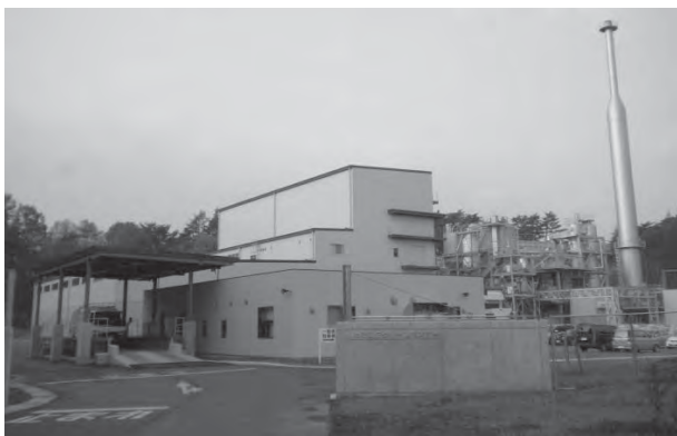
いわて第2クリーンセンター全景
