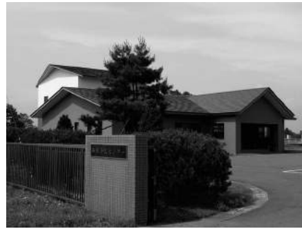
西根浄化センター
