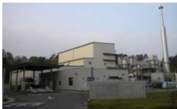
いわて第2クリーンセンター全景
