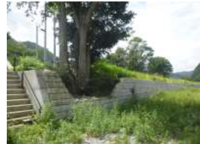
河川改修工事で河畔林を保全した安家川【岩泉町】
