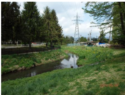
写真7 木賊川多自然川づくり（滝沢市）
