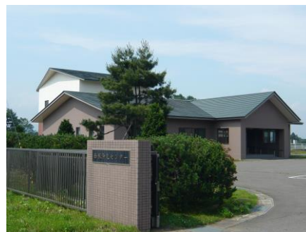
西根浄化センター
