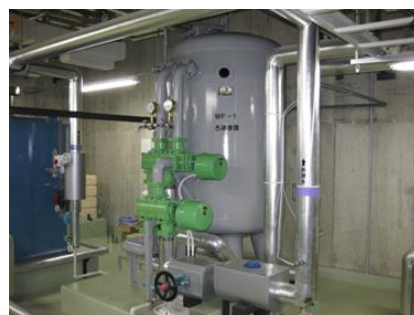
雨水貯留施設（二戸地区合同庁舎）
