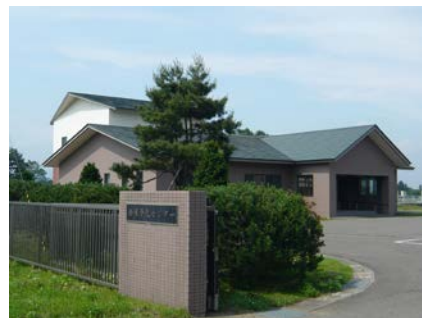
西根浄化センター
