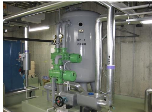
雨水貯留施設（二戸地区合同庁舎）
