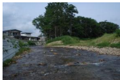
多自然川づくり（矢神川、八幡平市）
