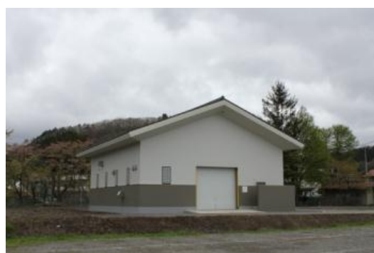
浄法寺浄化センター (二戸市)
