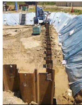
図 8-20 遮水壁（鋼矢板）の打設状況
