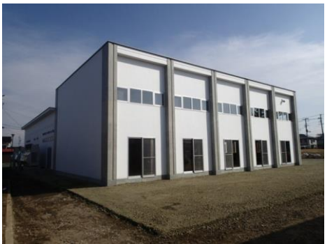
花北振興センター新築工事（岩手県花巻市）
