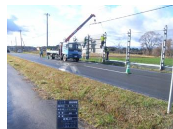
防雪柵の設置上げ下ろし
