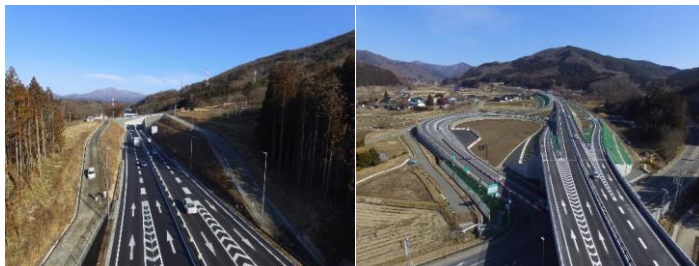
綾織地区構造物工事（釜石道）
