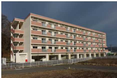
災害公営住宅新築工事（岩手県下閉伊郡山田町）
