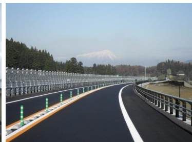
倉沢地区防雪柵設置工事 (花巻市東和町)
