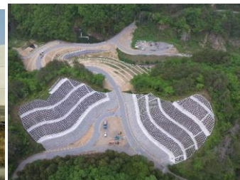
二級市道沼の浜青の滝線沼の浜地区道路災害復旧工事 (宮古市田老)
