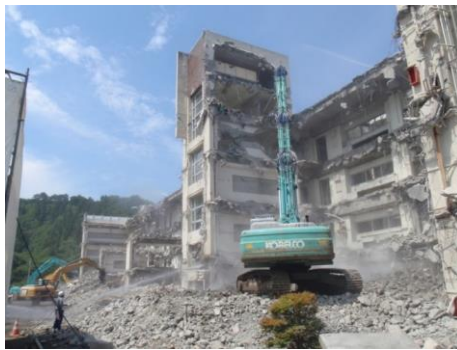
旧釜石商業高等学校解体工事（岩手県釜石市）
