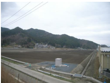
復興基盤総合整備事業下野地区工事 (上閉伊郡大槌町)
