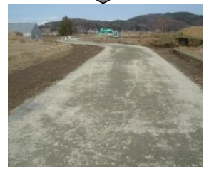
踏盤材として再生利用
