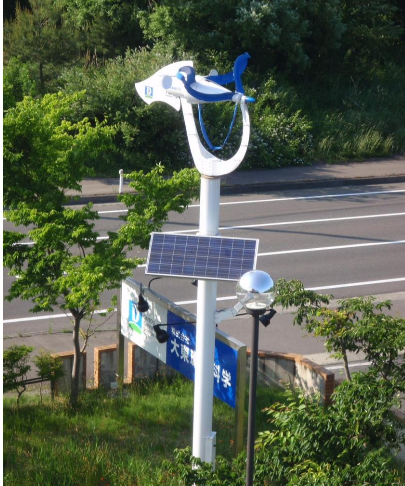
巻末写真：弊社出入口付近に設置されている小型風力発電機（夜間照明用）。
