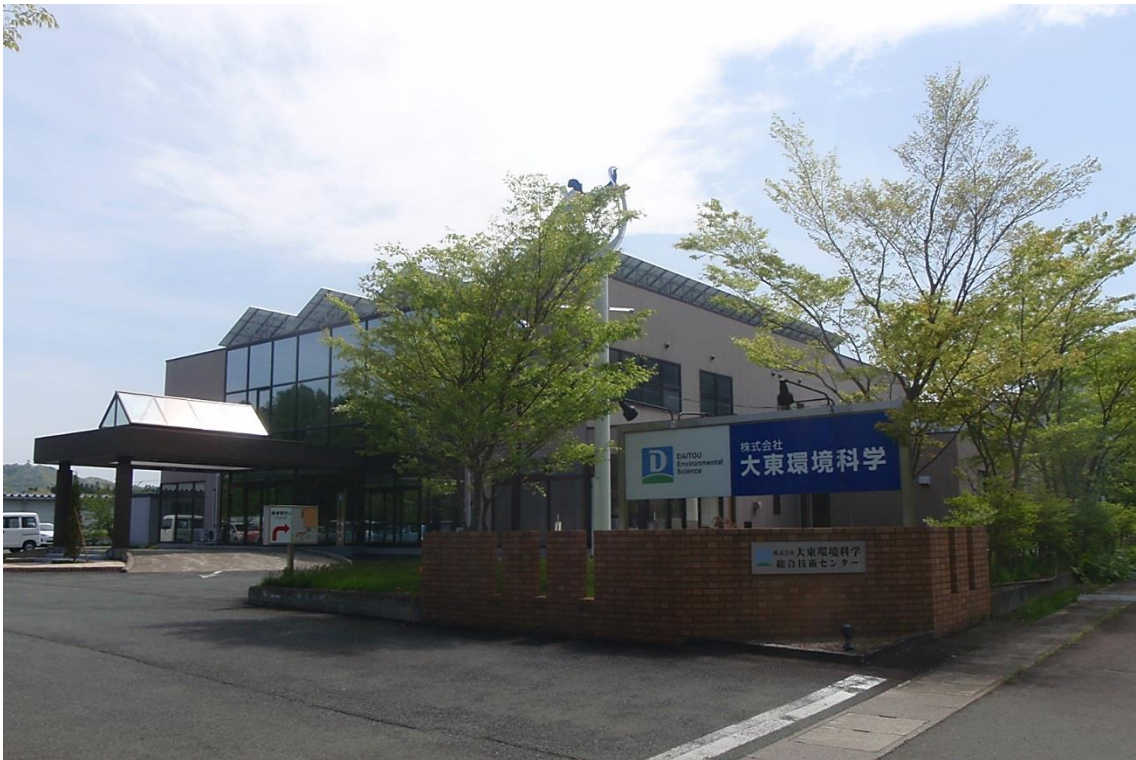
株式会社大東環境科学 総合技術センター 外観
