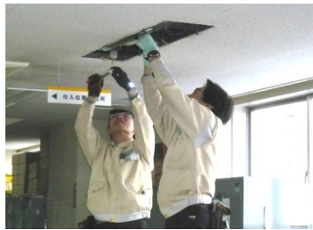
事務館蛍光灯LED化の作業中
