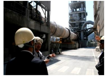
廃プラスチック類の焼成施設
