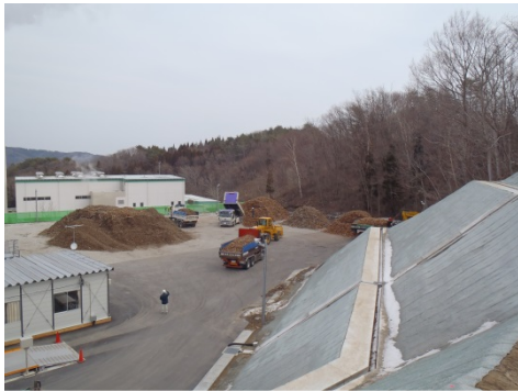
ごみ搬入ヤード搬入状況
